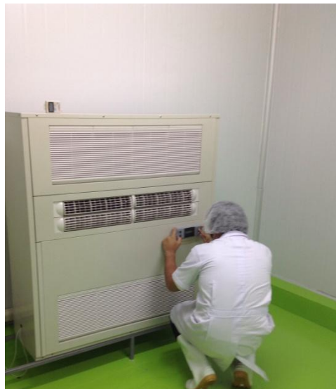
รูปที่ 3 แสดงเครื่อง Low temperature & low relative humidity drying ที่มีกรใช้งานแล้วติดตั้งในโรงงานผลิตอาหาร
