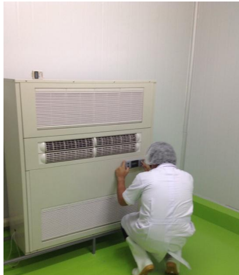
รูปที่ 3 แสดงเครื่อง Low temperature & low relative humidity drying ที่มีการใช้งานแล้วติดตั้งในโรงงานผลิตอาหาร
